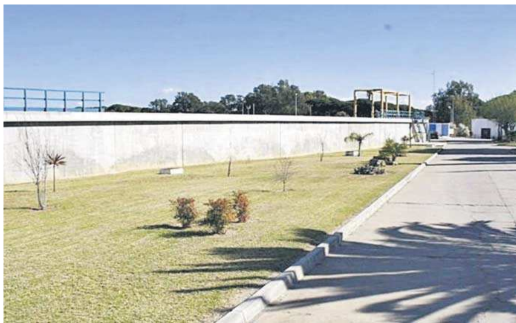
Una imagen del interior del recinto de la depuradora de Las Galeras.
