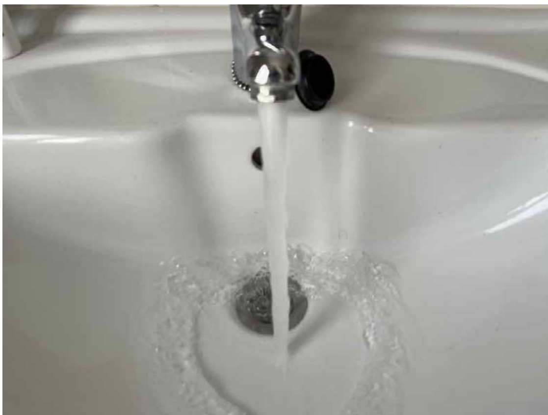
Una avería provoca cortes de agua en parte de Talavera
