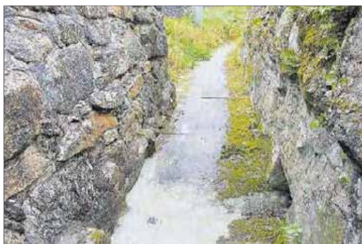
Canexa Fonte de Espiñeira, bajo la cual confluyen fecales y pluviales.
