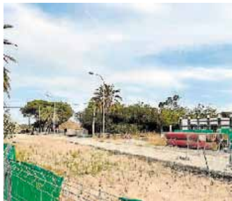
Obras de La Puntilla. :: J.Z.
